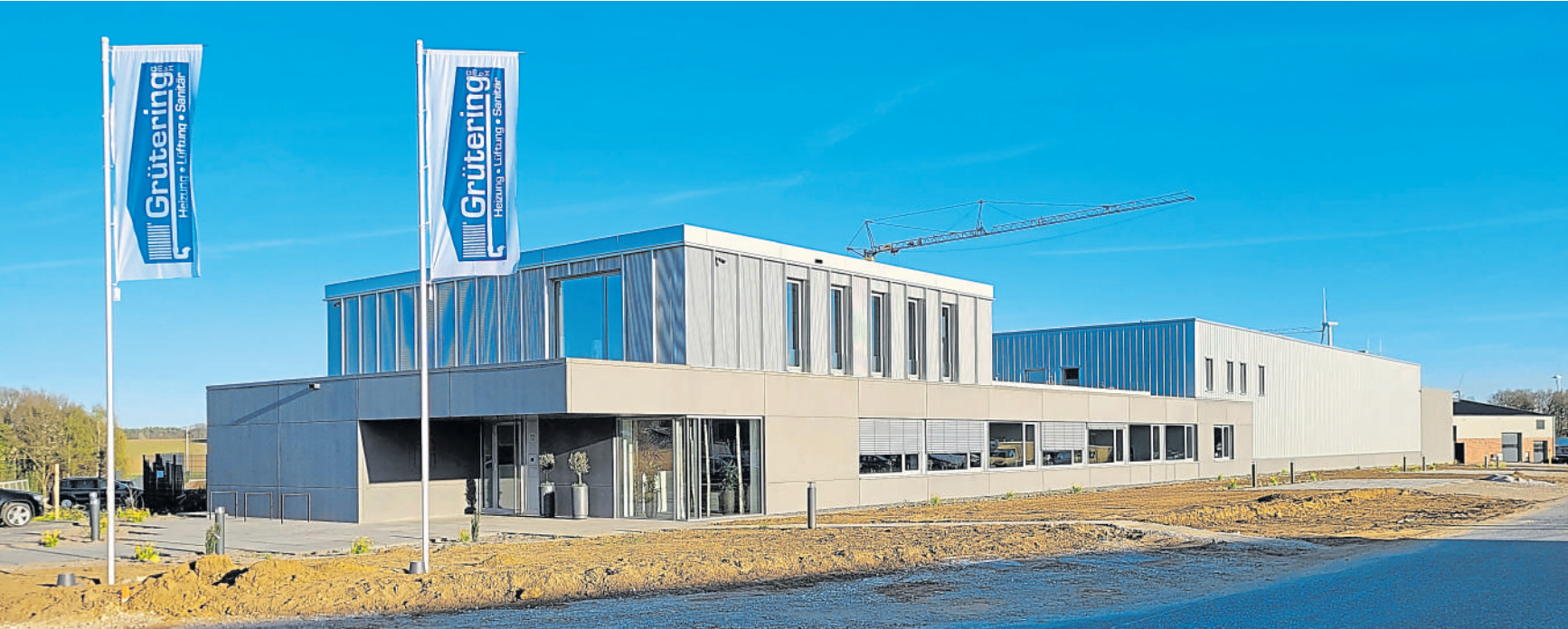
Die Firma Grütering lädt interessierte Besucher und Kunden ein, den neuen Firmensitz am Tag der offenen Tür kennenzulernen und sich über energetische Themen zu informieren.
