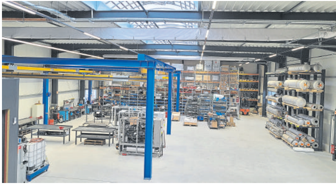
Die Produktionshalle: Voll klimatisiert und mit Tageslichtbändern.
