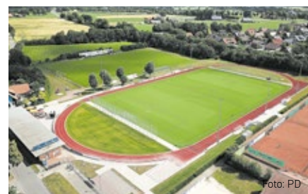
Den Sportplatz in Weseke hat die Niehaus GmbH & Co. KG neu gebaut.
